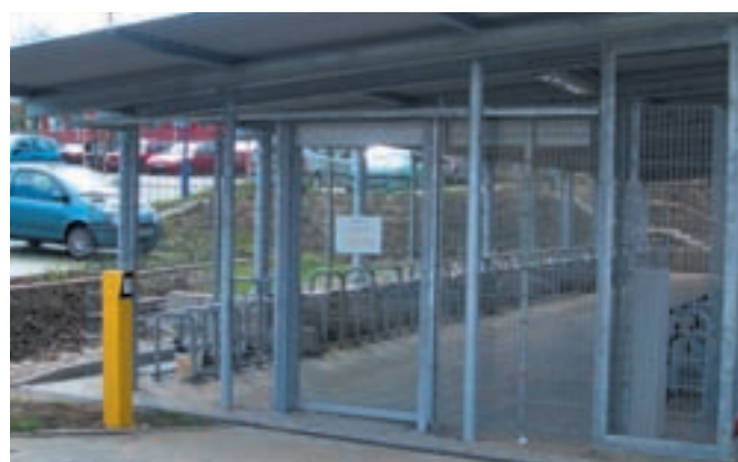
Gesichertes Radparken mit Zugangskontrolle
