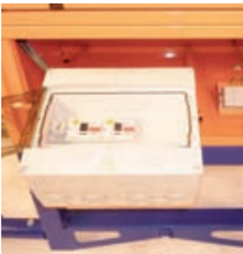
Technik-Schließfach mit Sicherungskasten
