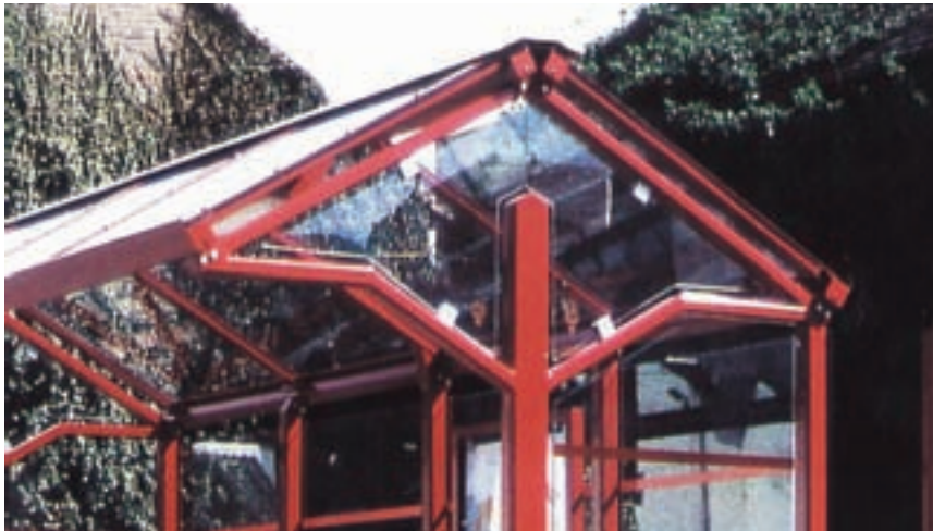
VSG-Dachverglasung mit geregelter Entwässerung und geschlossenem Giebel!
